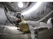
进入储罐作业
