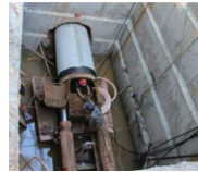
深基坑和地下管沟
